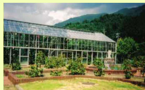
作業療法棟から見える広場
